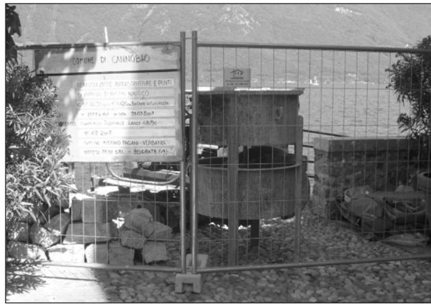
Il cantiere per uno dei nuovi pontili
